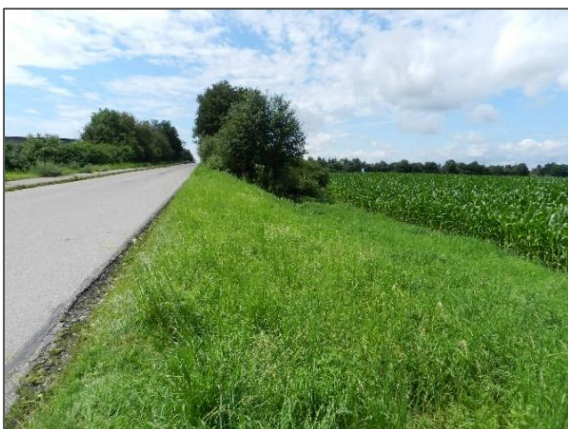
Abbildung 19: Illerstraße Blick Richtung Südwesten
